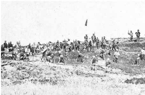
写真1 亀田桔梗野之境116番山ヲ崩谷地埋立之図 明治5(1872)年 田本研造撮影
