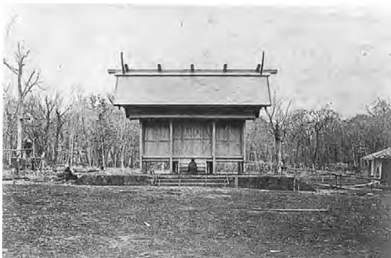
写真1 創建当時の札幌神社(正面) スチルフリート撮影
