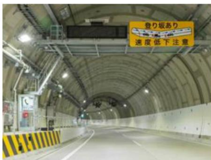
大和川第三トンネル
