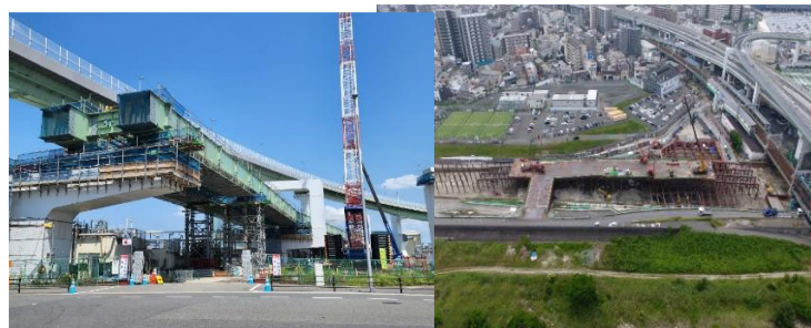
淀川左岸線（2期）建設中
